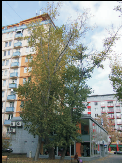
Stambeni kompleks Februarka, Bratislava, Slovačka
