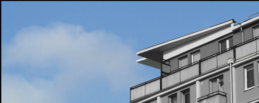
Stambeni kompleks Februarka, Bratislava, Slovačka
